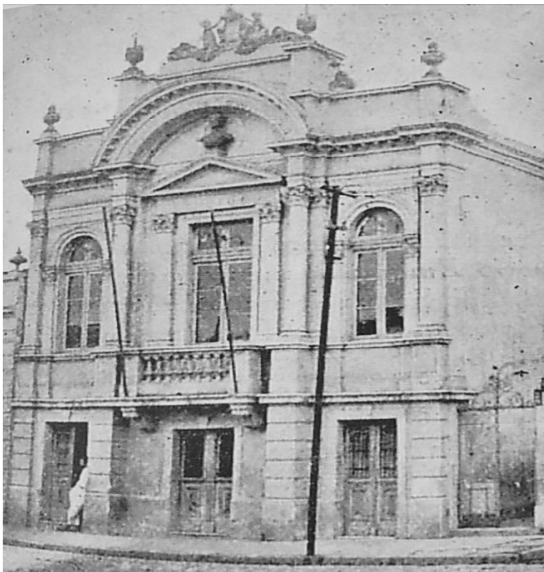
Figura 4: Società Elena di Montenegro, na rua General João Telles
